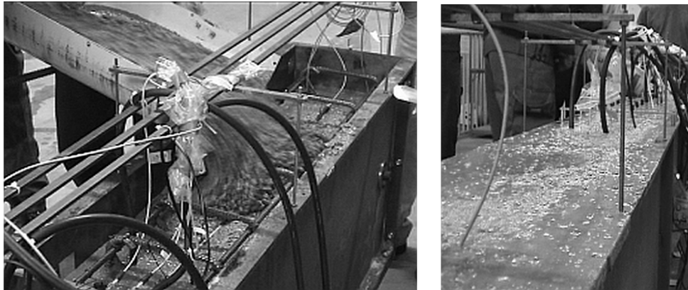
FIGURE IV.18: Mise en place du béton dans les coffres et début du séchage.
