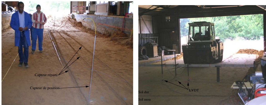
FIGURE IV.5: (Gauche) Mise en place des capteurs sur un plan. (Droite) Compactage du sol dur.
