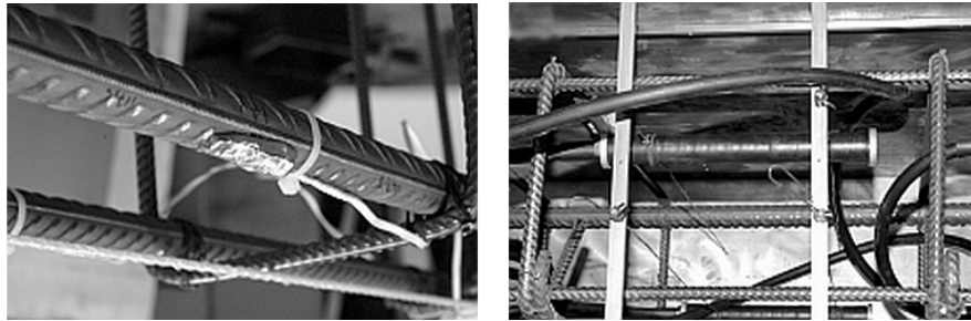
FIGURE IV.17: (Gauche) Un capteur de déformation placé sur les aciers. (Droite) Une jauge de déformation placée à l'intérieur de la structure.
