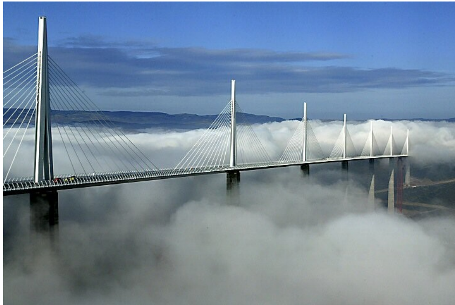
FIGURE I.1: Le viaduc de Millau.
