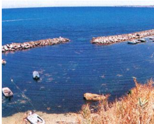
Figure 33. Diffraction d'une onde à la surface de l'eau
