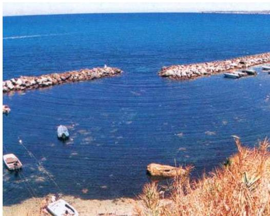
Figure 27. Diffraction d'une onde à la surface de l'eau
